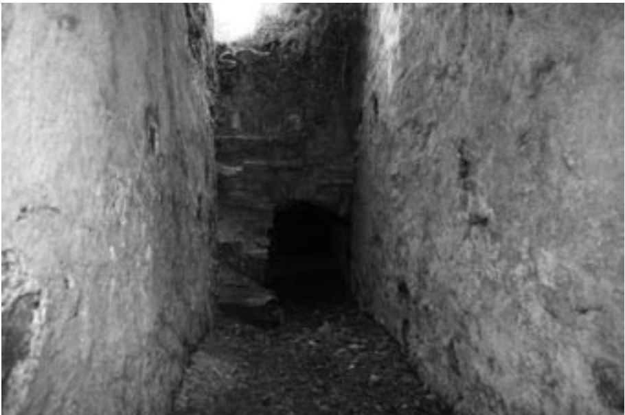
4. Mina de agua recubierta con muros de mampostería. Lagar de Almendrales (P.R. Almendrales).
