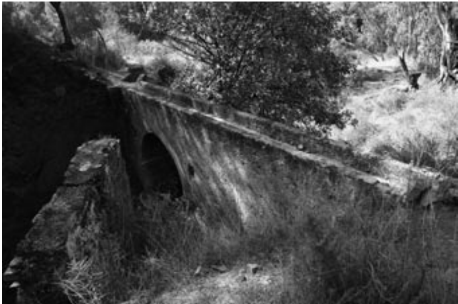
8. Pequeña atarjea de conducción de agua. Lagar de Urbano (P.R. Jaboneros).
