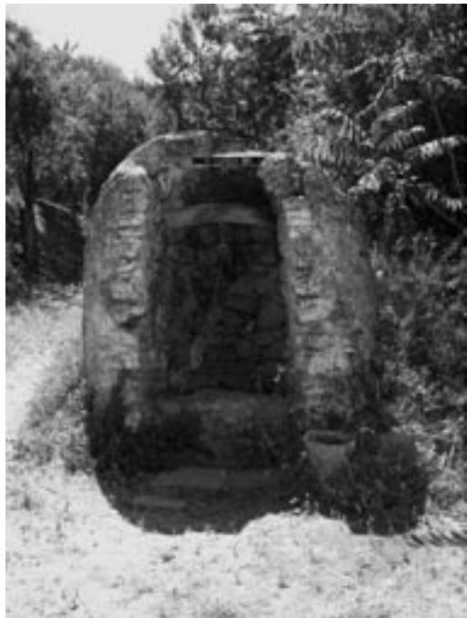
2. Pozo del lagar de Las Breñas (P.R. Cerro del Moro).
