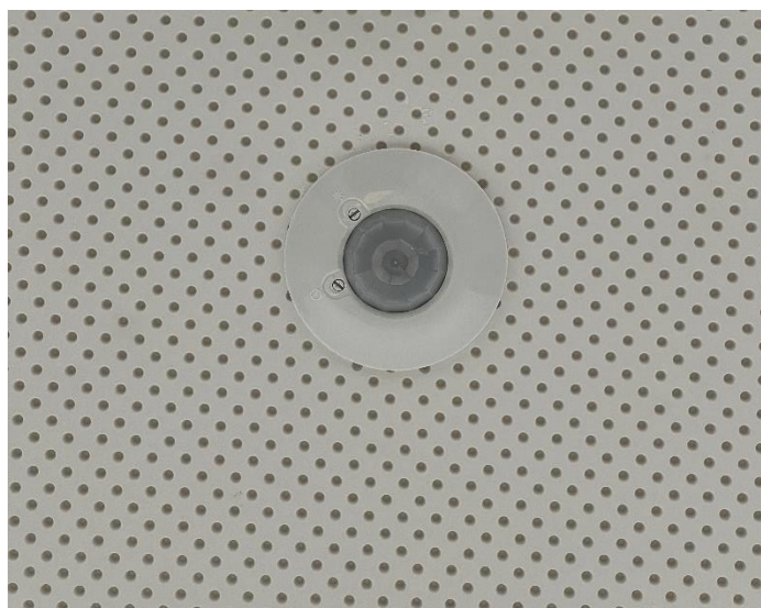
Imagen 2. Sensor de movimiento para activación de luces. Centro Senior Premium de Macrosad Arroyo de la Miel, Benalmádena. Tomada el 09/11/2023.
