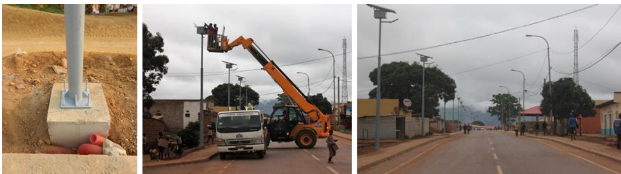
Figura 4. Cimentación, instalación y puesta en marcha de la instalación
