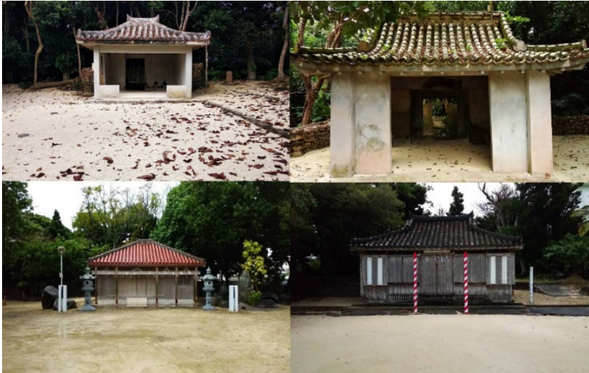
Figura 4. Ejemplos de salones de oración ( haiden/piden ). Parte superior (de izq. a der.): Mainu On , Ūrya On , aldea de Hazama. Parte inferior (de izq. a der.): Âmâ On , aldea de Tonoshiro, Miyatori On , aldea de Ishigaki, isla de Ishigaki. (Foto del autor, 2018, 2019).
