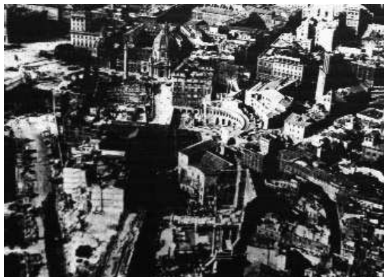
11. Demolición de los foros. AFC, 1932 ca.
