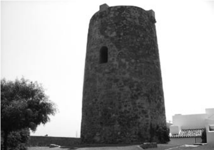
4. Torre vigía de planta circular
